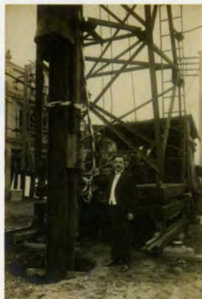
地下鉄工事現場と早川徳次 個人蔵
