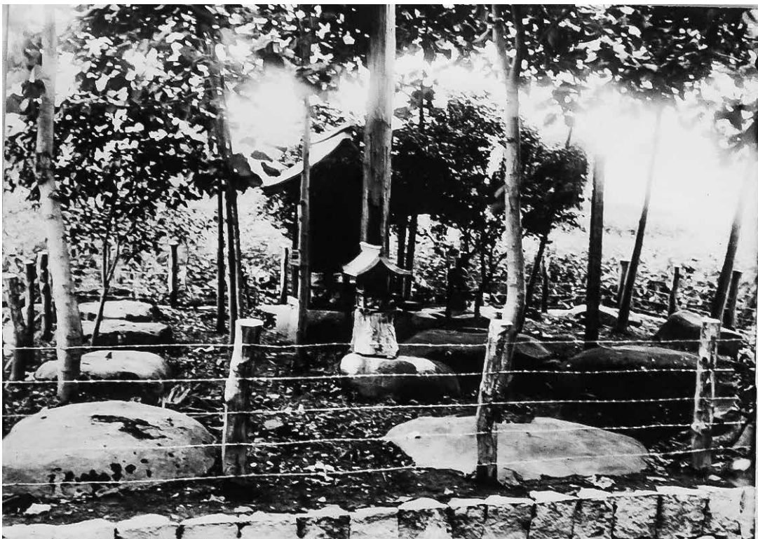
【写真1】大正10年頃の甲斐国分寺塔跡の保存状況 有刺鉄線で囲まれている。
