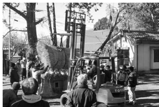
写真7 甲斐吹市八代町米倉のオコヤ作り 現代ではフォークリフトを用いて屋根を持ち上げる
