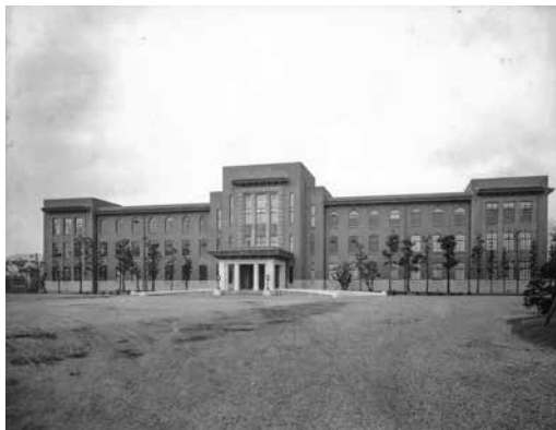
竣工当時の県庁舎別館 清水建設株式会社蔵
